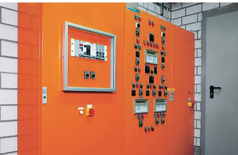
Quadro di comando e di regolazione per grandi impianti, montato su armadio separato.
